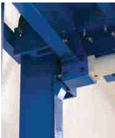
Détail du verrou de chargement et antidérive
